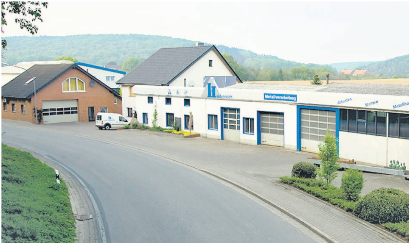
Blick auf das Firmengelände der Heidenreich Metallverarbeitung GmbH in der Meesdorfer Straße 28 in Melle-Meesdorf.
